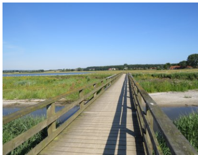
Die Brücke über den Broek
