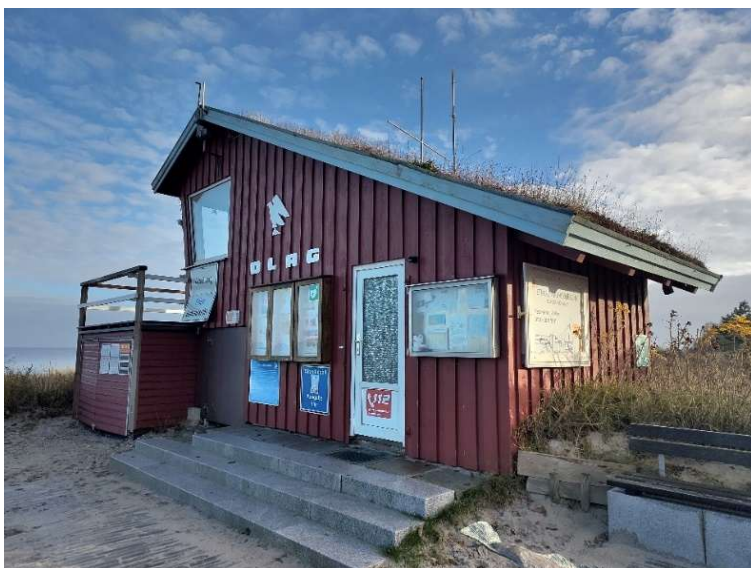
Abbildung 7: DLRG-Wache (keine Heizung)
